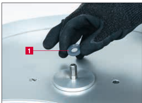
Рис. 7-15 Установка центрирующей шайбы на болт крепления
